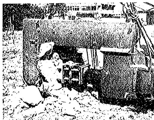
写真 2.19 油圧圧縮式コンクリート取壊し機械
