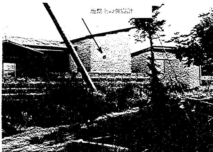
写真 1 - 5 地盤上の観測小屋
