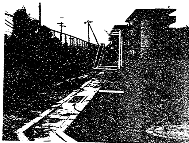
写真-1・10 排水側溝
