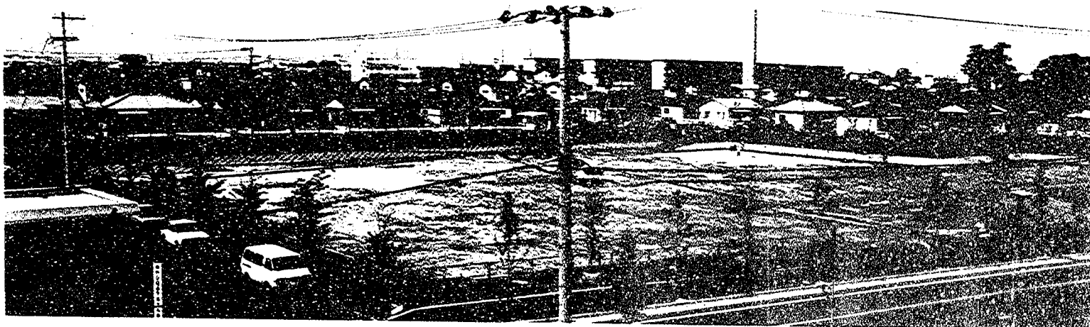
写真-1・26 佐賀県鍋島団地 高いグラウンド面は暗渠排水している。 右側手前の低地部に排水口あり。
