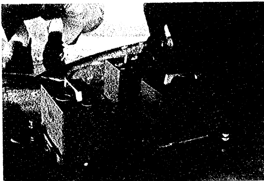
写真－3.1 P_4 橋脚上の地震観測用換振器
