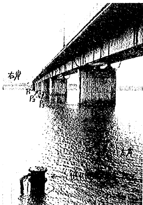
写真-1.1 新飯野川橋（左岸側堤防から撮影、手前は地中地震計用ケーシング）
