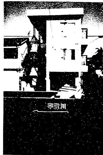
写真-5 ピロティ式の例 愛知県鍋田干拓地の住宅
