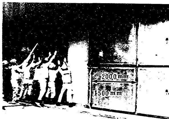
写真-14-4 板一枚の重量は約 100 kg
