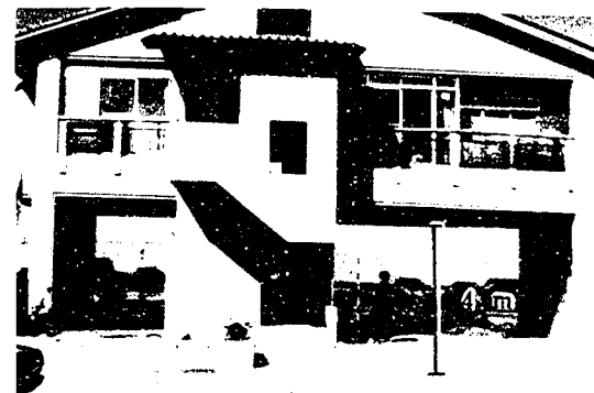
写真-5 ピロティ式の例 愛知県鍋田干拓地の住宅
