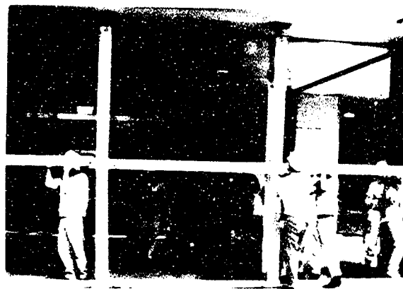
写真-14-2 柱を組み立てる
