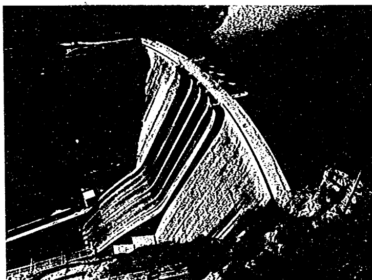
Fig. 38. Salime Dam completed. Power plant is under spillway. Barrage de Salime achevé, Usine sous le déversoir.
