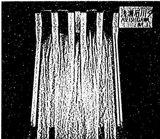
堤体下流面の流れ（ピア下流の分離壁をはずした場合） 放流量 2400\text{ m}^3/\text{s} ，貯水位 EL. 199.0m
