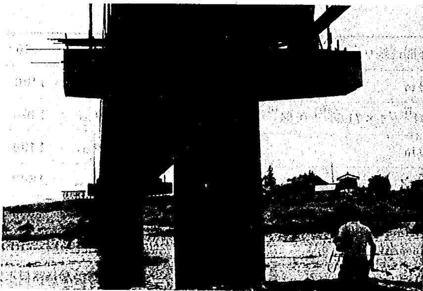
写真1-2 伊達橋 P 2 橋脚（強震計は橋脚中央に設置されている）
