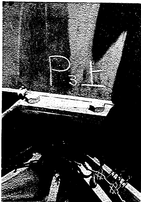
写真2-11 抜け出し寸前のピン（P 3 橋脚下流側可動沓の外側）
