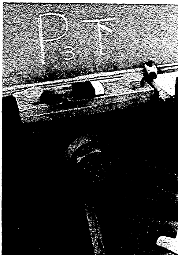
写真 2 - 9 抜け出し寸前のピン (P 3 橋脚上流側可動沓の外側)
