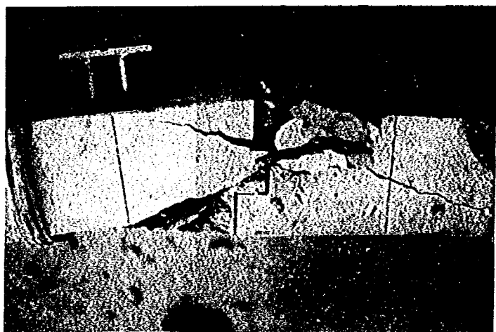
写真-5.6 ブロック覆工の破壊状況
