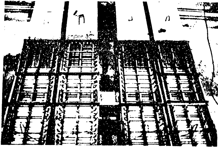
写真－3 I形鋼格子床版供試体製作 (第1期工事部分施工後)
