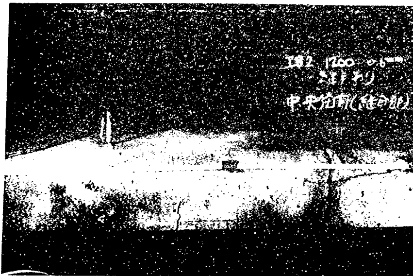
写真－ 7 I 形鋼格子床版 2 分割施工供試体中央径間 載荷試験後 ( I - ビームにそったひびわれが見られる )
