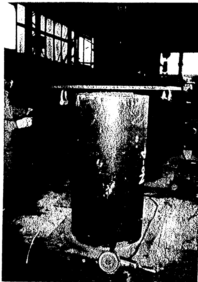
写真－6 端板の取付け
