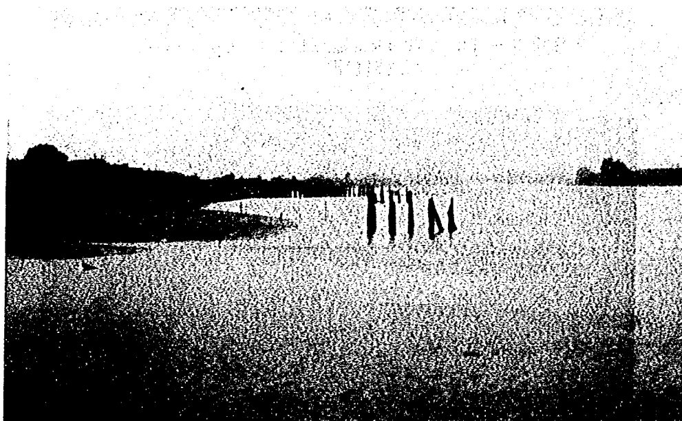
写真8-19 32.3 km 地点の左岸 杭出し水製の破損状況
