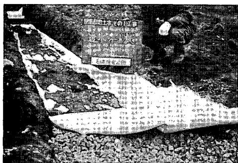
写-3 浸透地下トレンチ上部透水シート敷き
