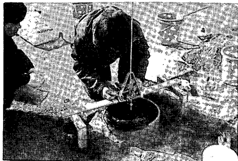
写真-4 ポイントゲージの据付けおよび調整
