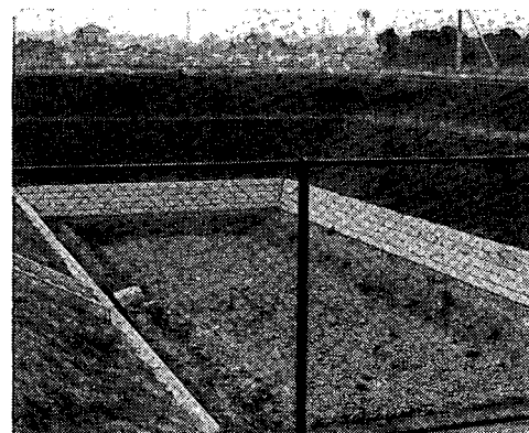
図-28 瑞穂町土地区画整理組合の防災調整池 (排水はすべて底面からの地下浸透による)
