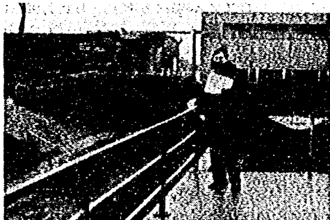
写真-22 Ölbach 川と処理場の流入渠
