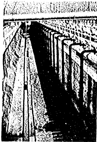
写真-5 Buchenhohen 処理場, エア レーションタンク散気管
