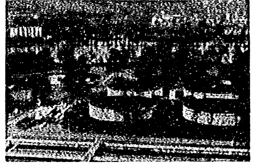
写真-18 Hagen 処理場，後段散水汚床および最終沈殿池
