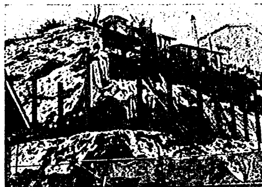
写真4-4 杭の建込み
