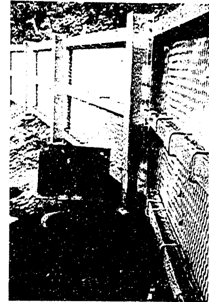
施工中（エキスパンドメタルの取付）
