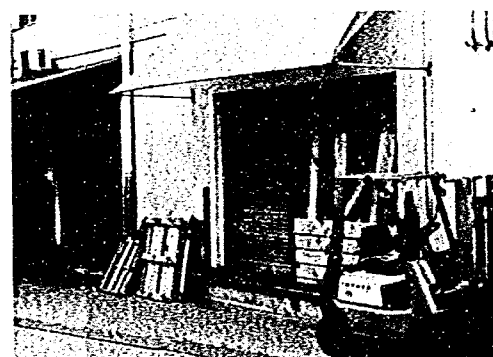
写真-2.20 木製防水板(神田川流域)
