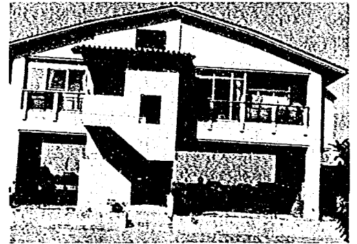
写真-3・17 ビロティ化住宅（N-30） （鍋田地区）
