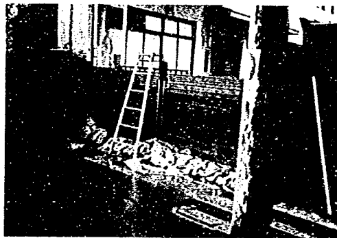
写真-2.4 塀で防除する一木製防水板一 (神田川流域)(昭和56年撮影)
