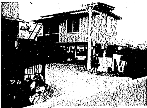
写真－3・3 飯田市川路のビロティ式住宅 （災害危険区域第2種区域）
