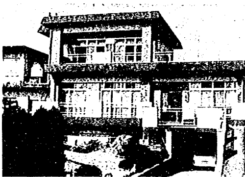
写真-3・16 昭和48年に増築された高床式住宅（鍋田地区） 左は伊勢湾台風災害後に建てられた住宅（N-29）
