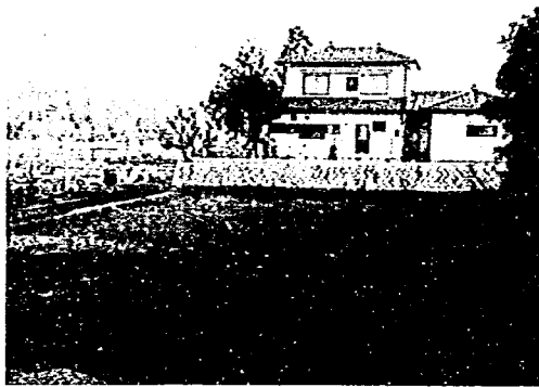
写真－3・2 飯田市川路の盛土 （災害危険区域第2種区域）
