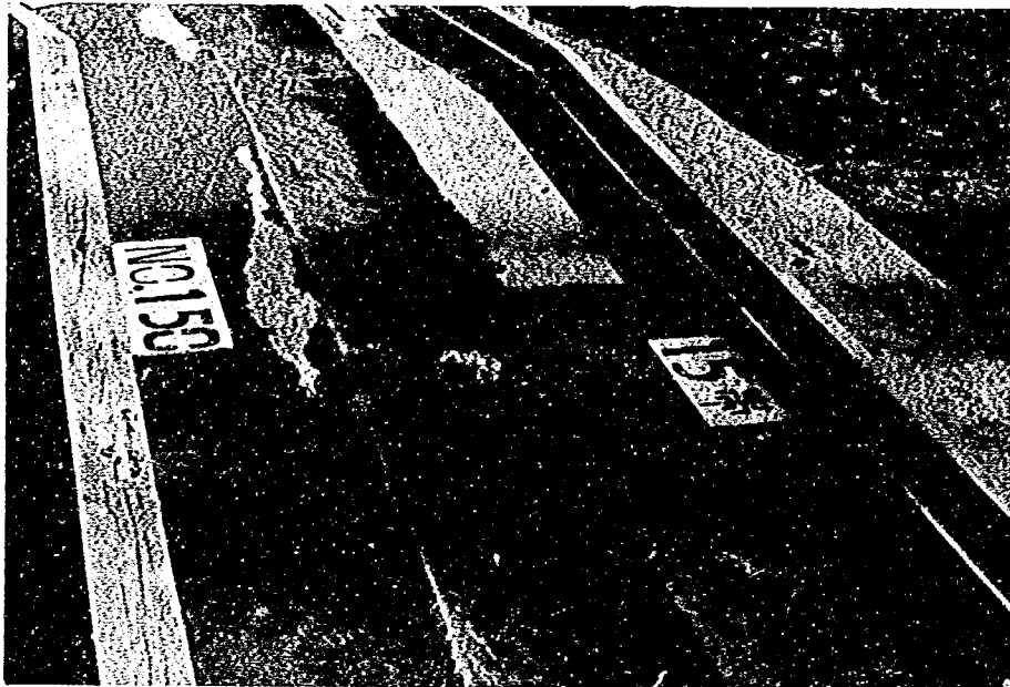
写真－4 15号帯工の上流面が洗掘されて、流水は跳水し護岸越 水が生じている状況（計画高水流量） この区間の上・下流は固定床であり、帯工の上・下流間 の洗掘を大きくする。
