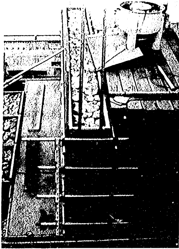
写真-1 モルタル注入前のフトンかごの壁
