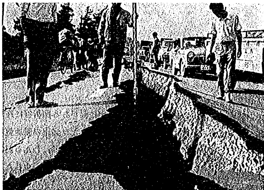
写真-1 新潟県西蒲原郡黒崎村善久(国道8号線)の被害状況(Ⅲ型破壊)
