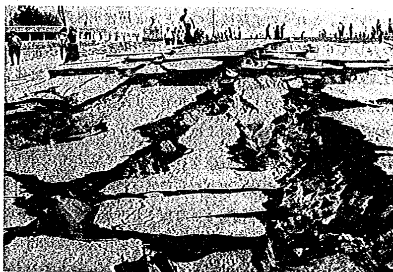
写真-2 昭和大橋左岸取付道路(県道)の被害状況(Ⅲ型破壊)
