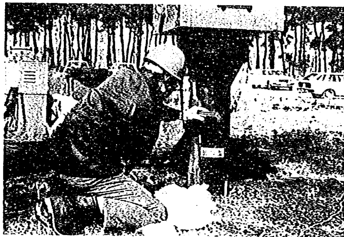
写真10 モデル実験機の共振杭打実験 その2 (杭深度11m付近)
