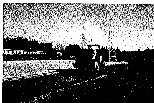
写真Ⅲ-4 車輪式トラクタショベル の走行
