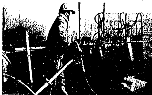
写真Ⅲ-14 レッグドリルによる削孔 (レッグ角 45^{\circ} )
