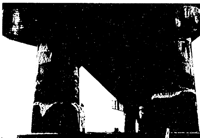
写真-1 橋脚被害
