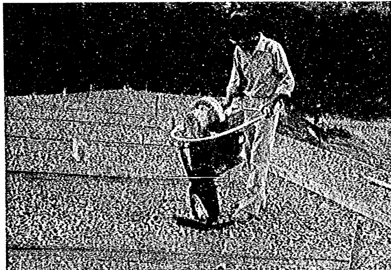
写真一 7 横断板間に平均厚 5 cm の敷砂利を施し転圧する。
