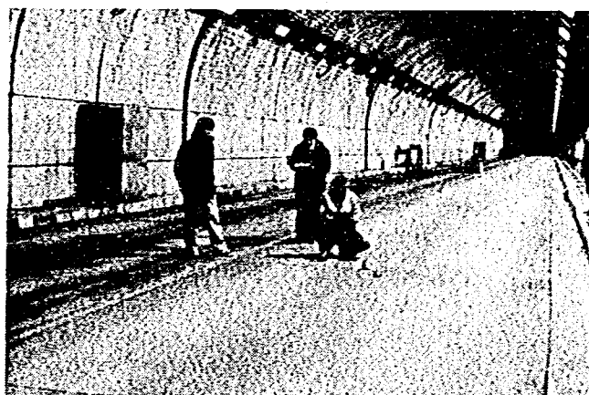
写真 4. 5. 路面照度測定状況
