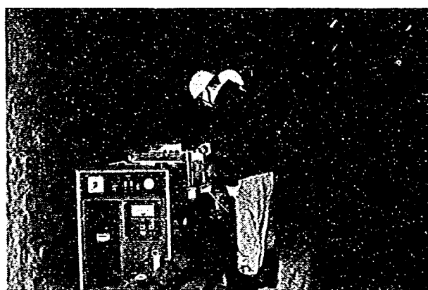
写真-2.4 CO計その他設置状況
