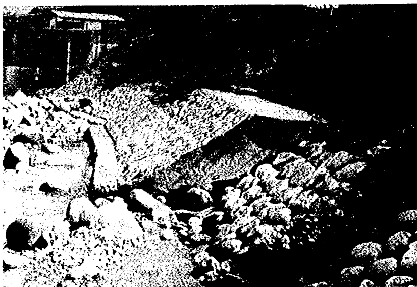
写真－2 護岸の破損状況 (No.8 付近)
