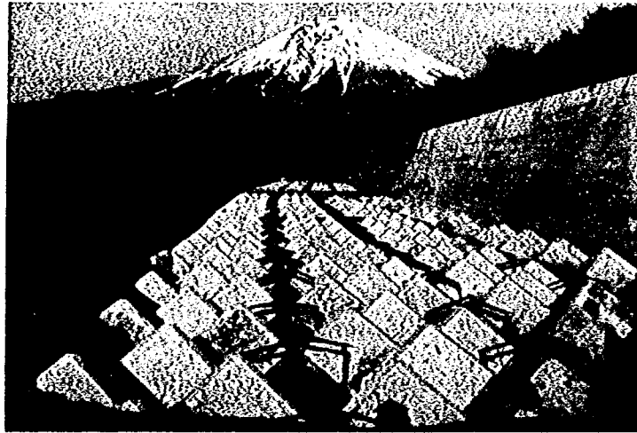
写真-1 溪岸工の状況
