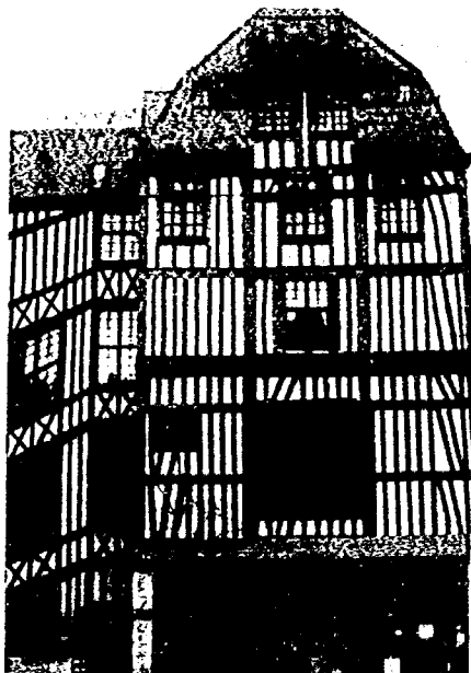
写真-3.8 ルーアンの歴史的地区 “シャルパントリー”と呼ばれる木の骨組を 表面に見せた建物
