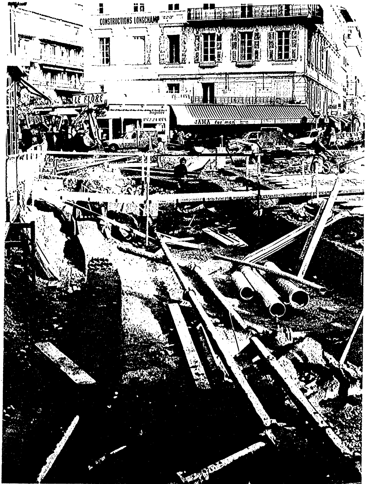
ニース市マジェンタ広場（工事中）
