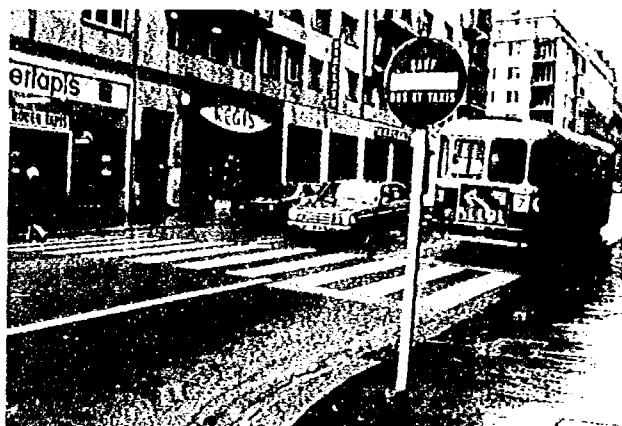
写真-3.10 ルーアンのバス専用通行帯 一方通行に逆行するバス専用通行帯で、バス とタクシー が通行できる。
