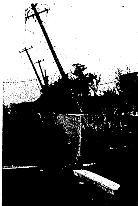
写真-14 電柱の傾斜（日本海 中部地震）
