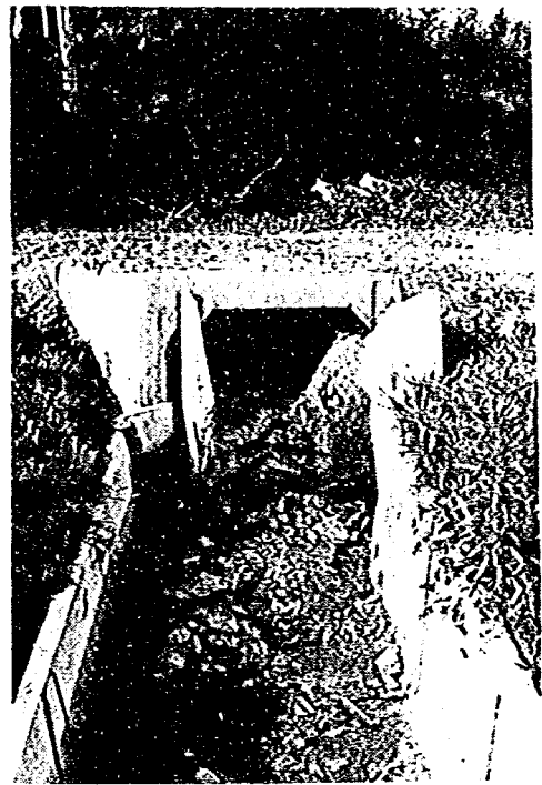
写真-12 排水側溝の破損（構造部 接続部，日本海中部地震）
