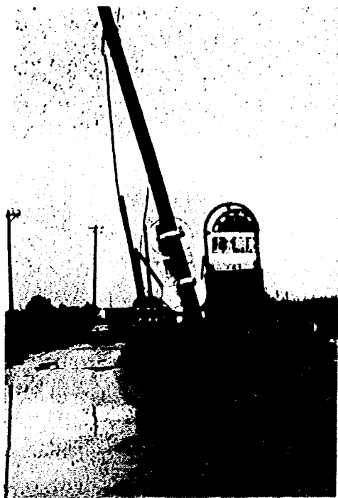
写真-13 電柱の傾斜（日本海 中部地震）
