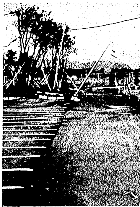
写真-15 街路灯の傾斜（日本 海中部地震）
