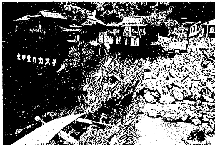
写真-8(a) 被害箇所No 7の路面埋没, 路肩崩壊状況
