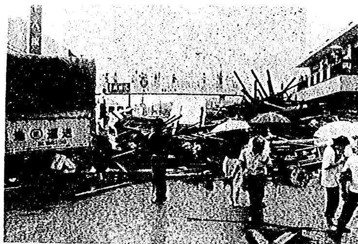
写真－ 2(c) 東長崎地区の道路状況
