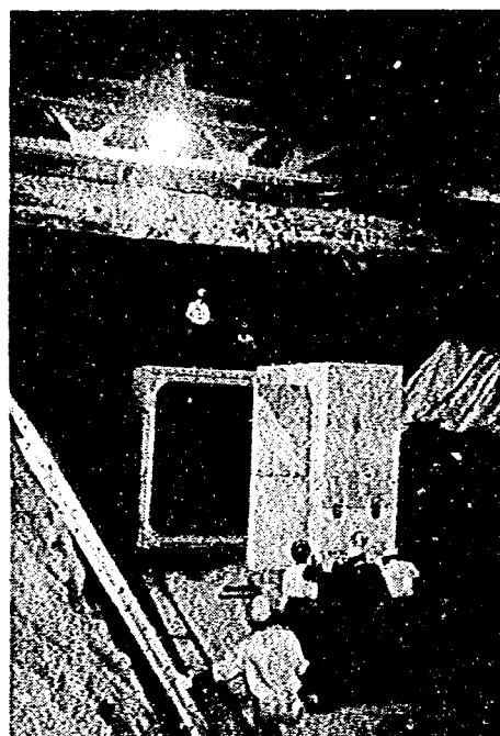
写真－ 9(c) 被害箇所№ 8 のBoxカルバートの設置工事状況
