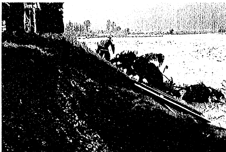
堤防浸食の拡大を防ぐ木流し工(安倍川静岡市松野地先)
