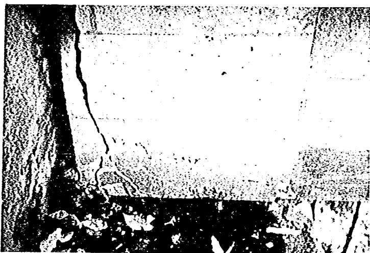
写真 3.30 黒瀬橋の R C 桁端の破損
