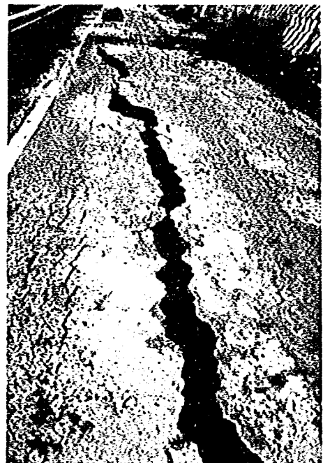
写真 3.4 路面の亀裂（県道越木曾福島線）
