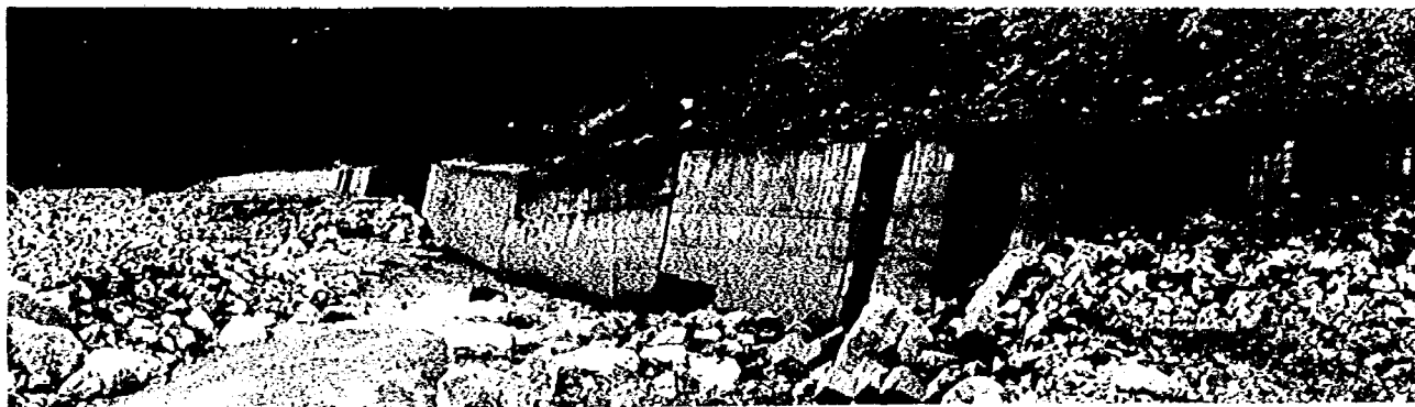
写真-1 護岸被災状況（上流より望む）
