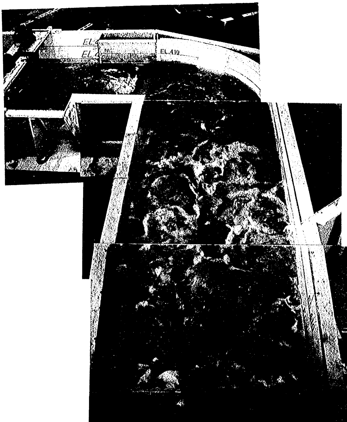
形状 6 (将来水位) 流量 = 5,000 \text{ m}^3/\text{s} (計画最大放流量)
