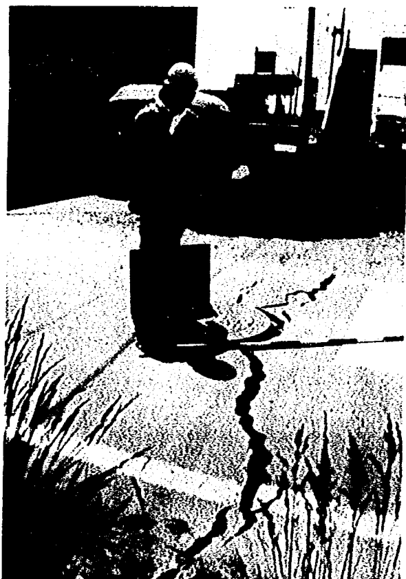
写真 1.51 国道 7 号線，能代市西大瀬 取付道路（盛土部）において人孔位置で発生した亀裂の状況
