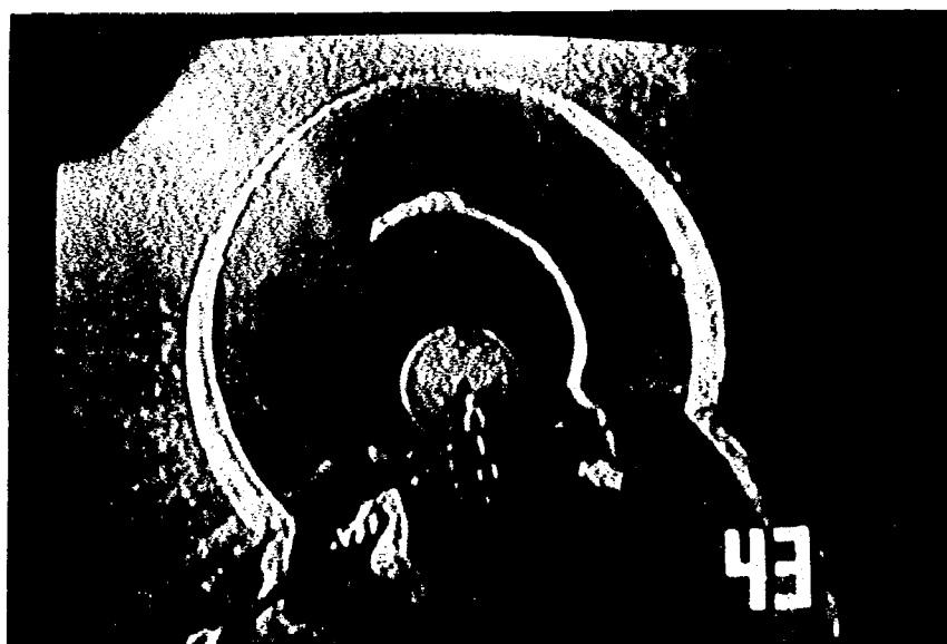
写真 1.27 旭川東排水区（枝線），秋田市南通亀の町 （ \phi 300，埋設深度 1.7 m，昭和 7～15 年施工）
