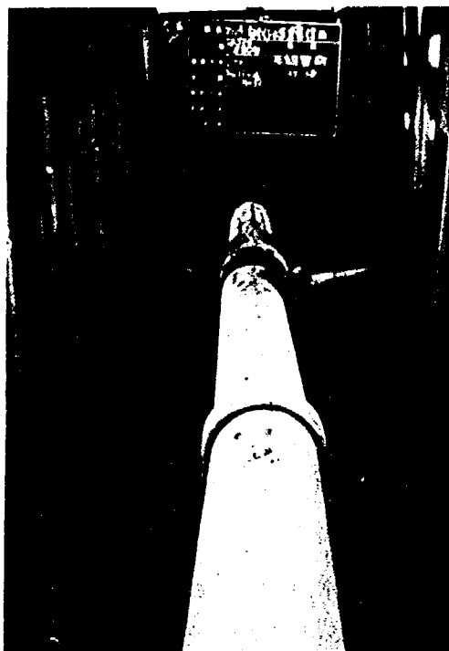
写真 1.28 旭川東排水区(枝線), 秋田市川尻町字川口境 ( \phi 250, 埋設深度 1.5 ~ 1.8 m, 昭和 56 年施工)
