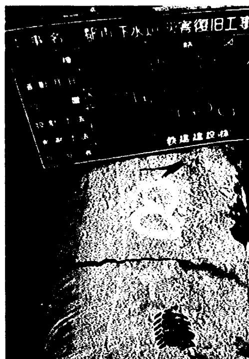
写真 1.13 土崎港西幹線，秋田市土崎港西1丁目 (φ500，埋設深度 3.5～4.5 m，昭和57年施工) 写真 1.11と同じ路線，管体円周方向の亀裂状況。
