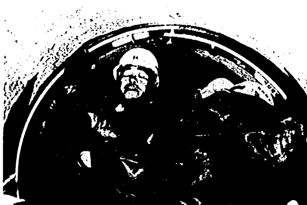
写真 3.43 管目地部への止水バンド取付作業 (秋田市榎山本町～川尻大川端地内)
