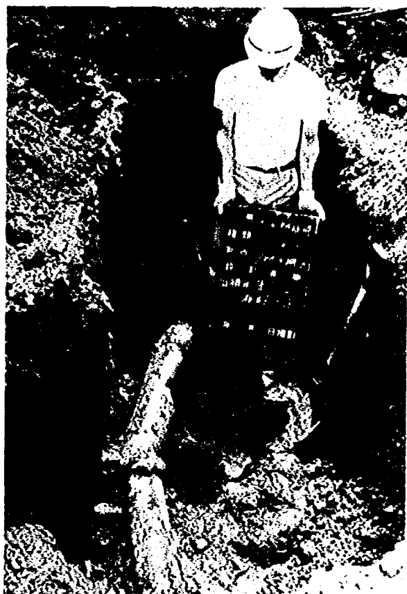
写真 1.20 新屋第 1 排水区，秋田市新屋元町 雨水マス（写真上）からの取付管の被害状況で，地盤変状による管の蛇行が生じている。管体には円周方向に亀裂が生じ，継手部もソケットが破損している（図 1.3 土質柱状図参照）。
