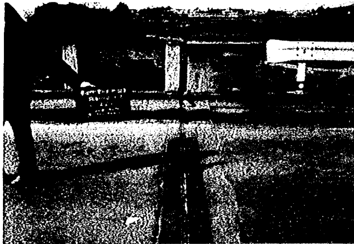
写真 2.4 突き合せ型伸縮装置
