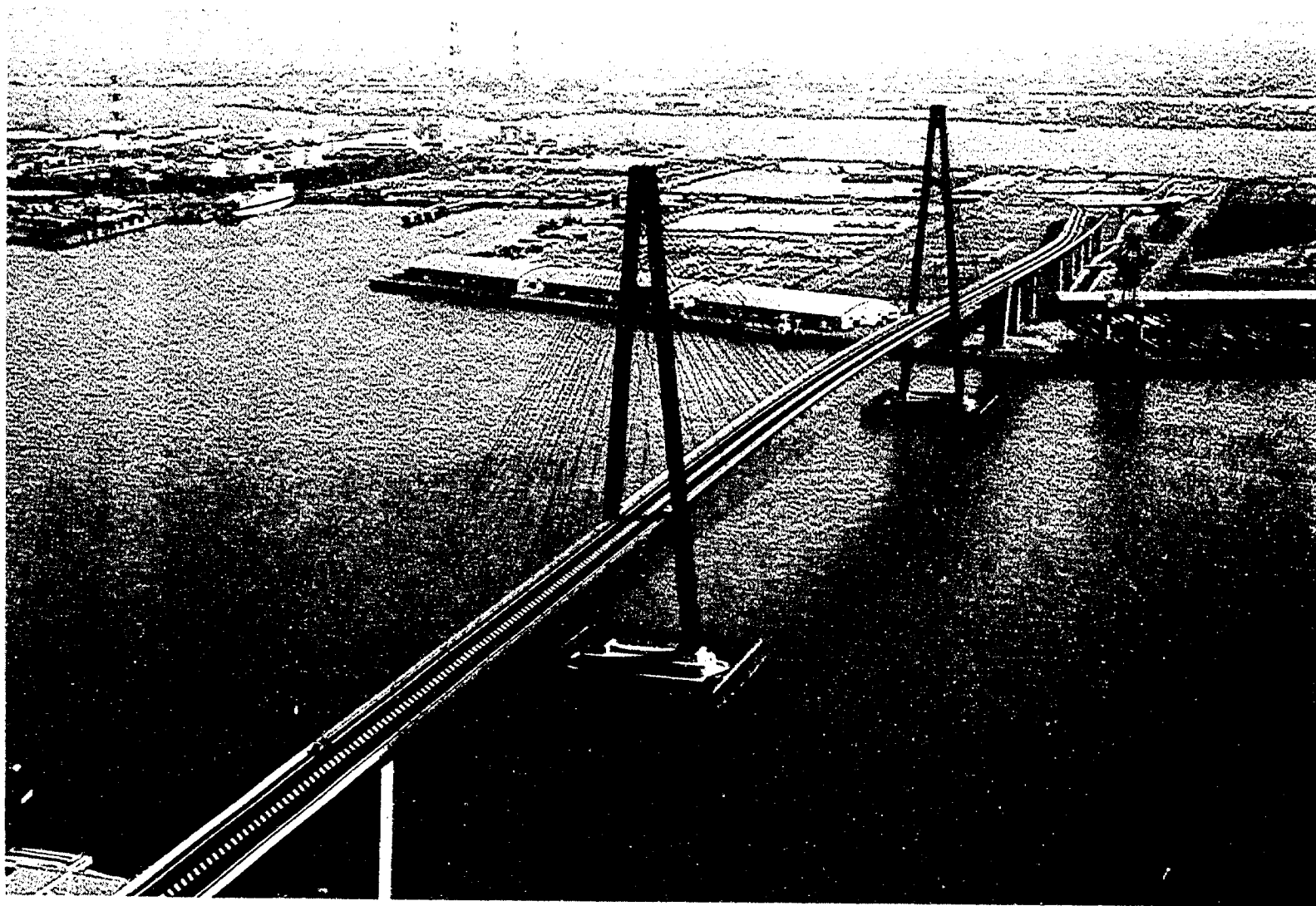
写真－2.2 名港西大橋全景（その2）
