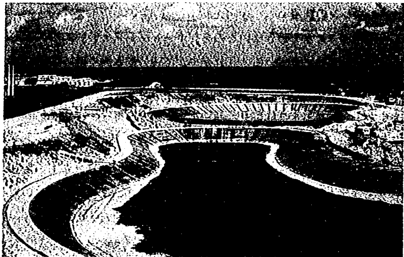
写真-23 ジオメンブレンを用いた貯水池の施工例（フランス）
