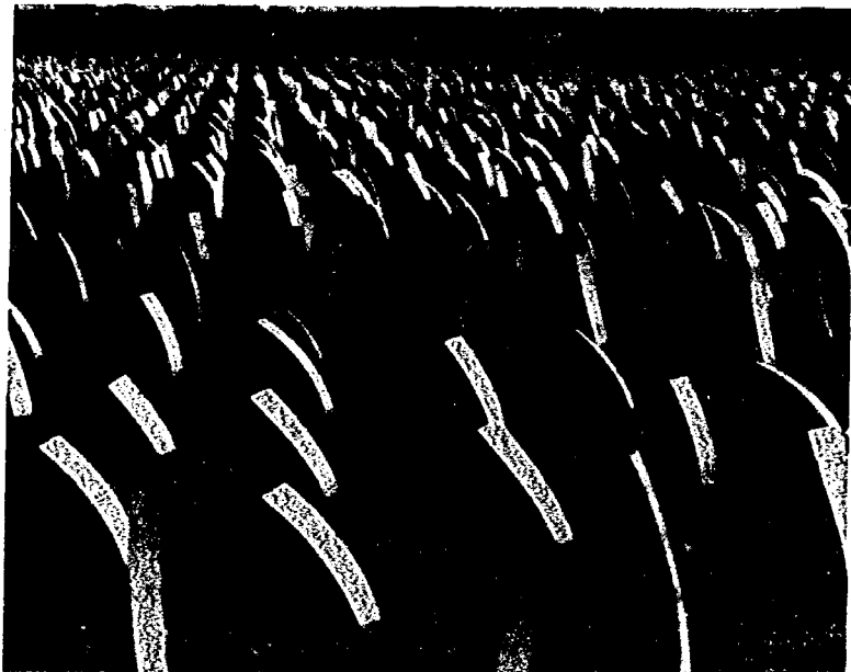
写真-8 プラスチックドレーン材を用いた圧密促進工法の施工例
