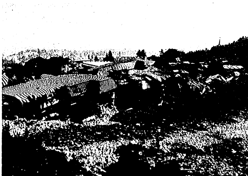
写真14 破壊された松寿荘 (8月2日)
