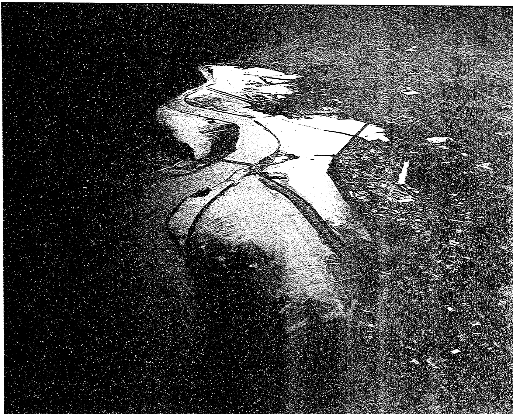
昭和 57 年台風 10 号による桂川の氾濫状況 (亀岡地区：28.8 km～32.8 km)
