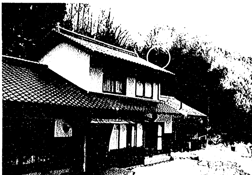
写真－ 2 0 同報無線戸別受信アンテナ（白門内）
