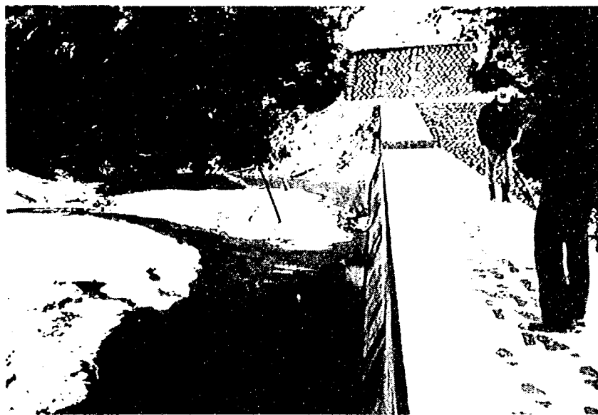
写真－ 1 7 中村川ダム堆砂状況
