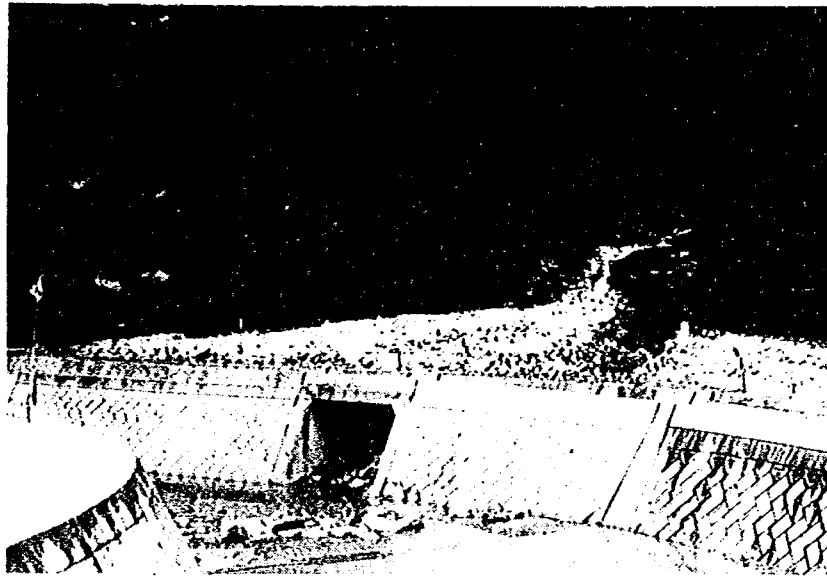
写真－５ 土砂流出状況（滝見川）
