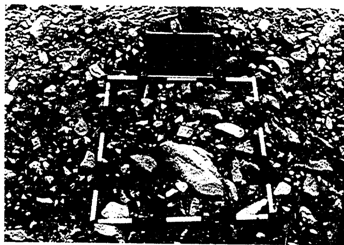
写真-8 洪水後の河床の状況〔C地点〕（写真提供 島根県浜田土木建築事務所）
