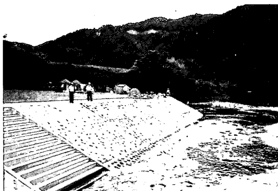
写真一 103 大千瀬川（愛知県） 高水敷上のキャンプ
