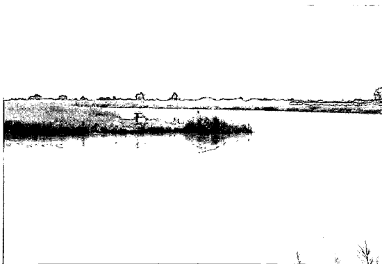
写真一54 岩木川……合流点の導流堤
