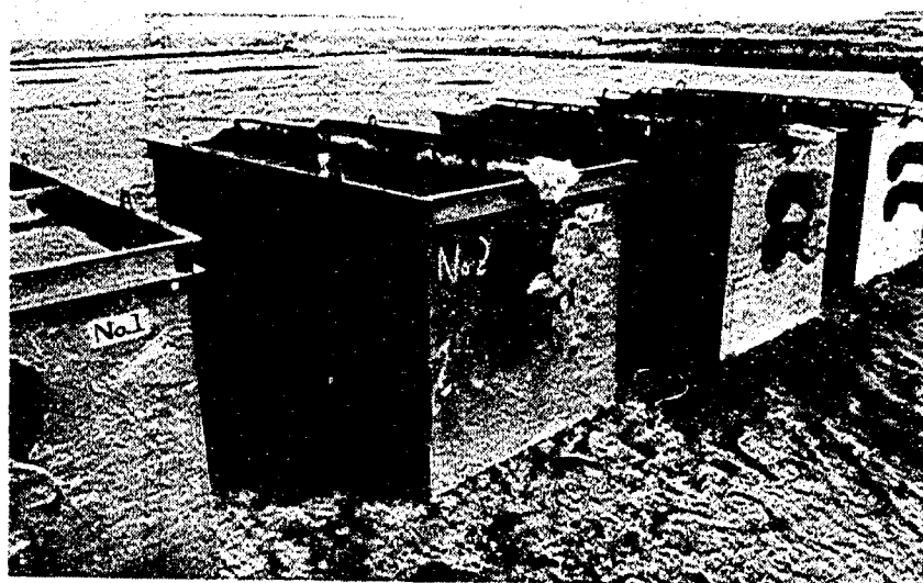
写真-3.3 配泥完了時
