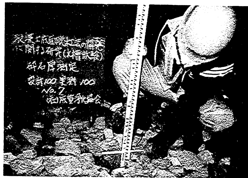
写真-3.6 砕石設置状況
