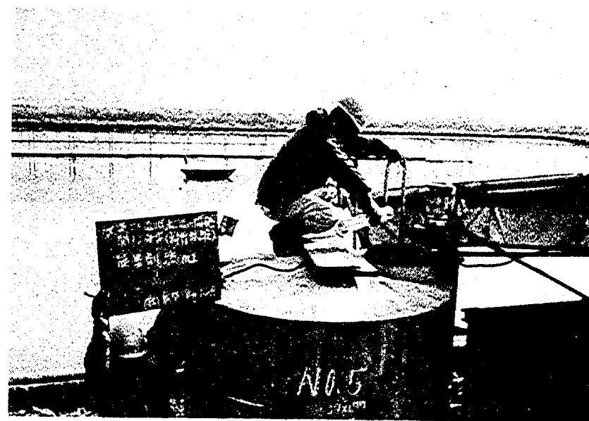
写真-3.8 凝集剤添加状況
