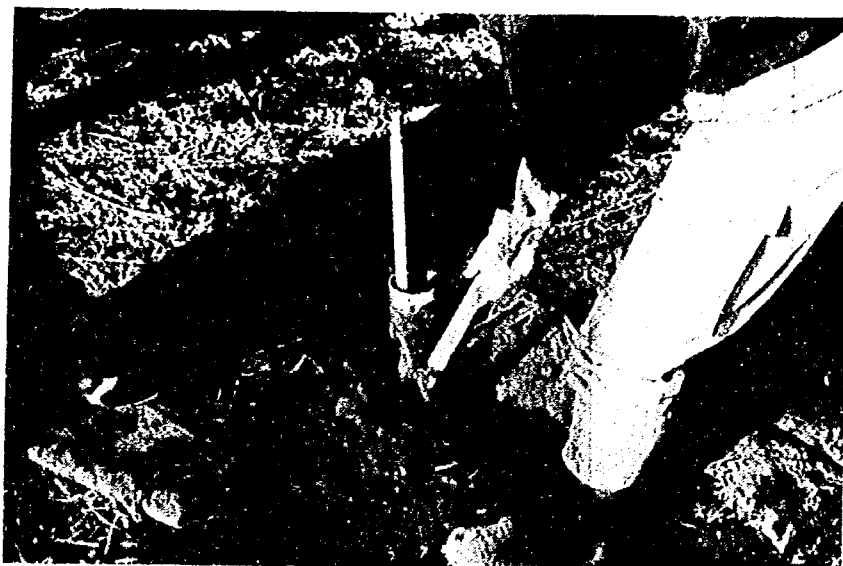
写真 3. 6 地中加速度計の埋設
