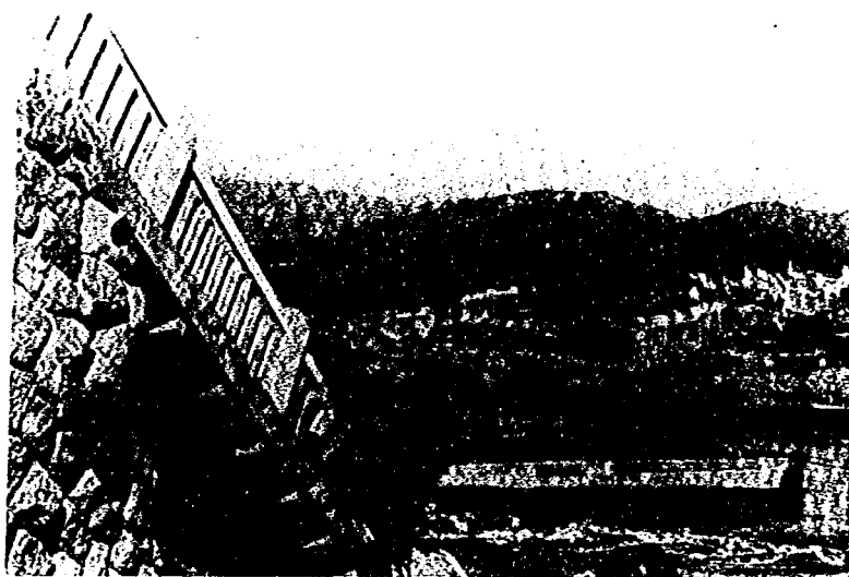
写真-1 関東地震による酒匂川橋の震災状況
