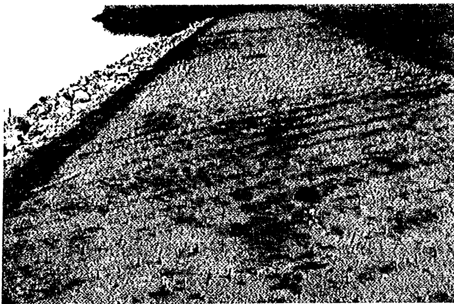
図 72 ヤナギの挿木をした河岸の平らな法面
