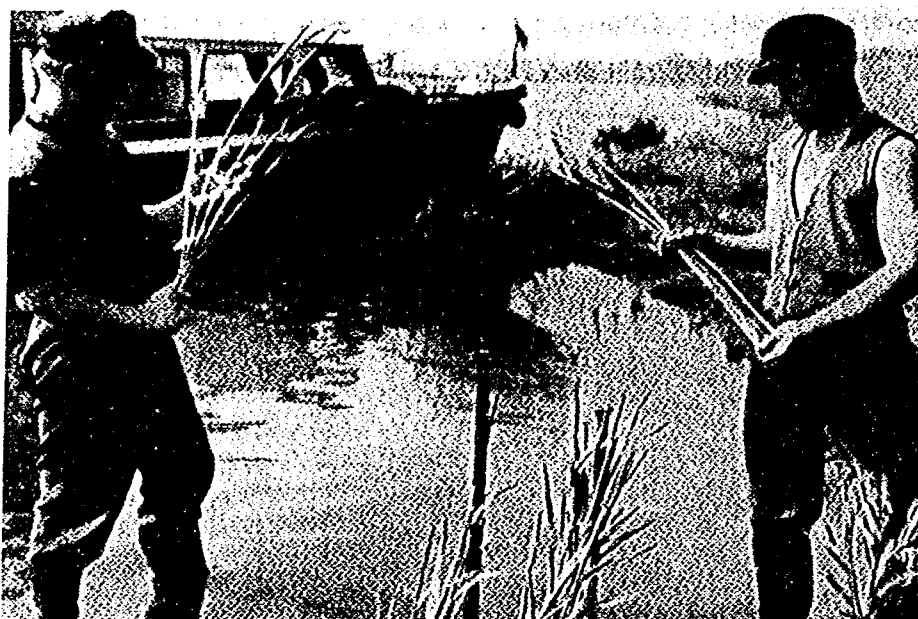
図 59 淀んだ流れの無防備の河岸におけるヨシの茎植えの方法
