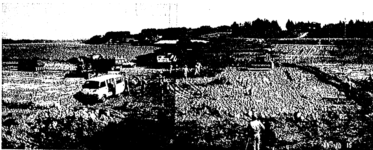
写真-5 転圧試験ヤード
