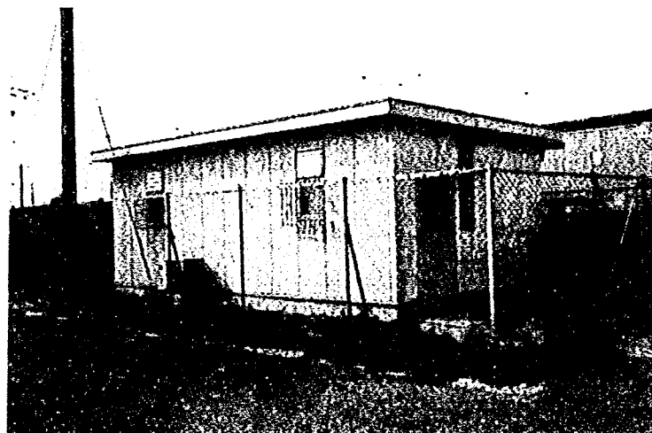
(a) 観測小屋の外観
