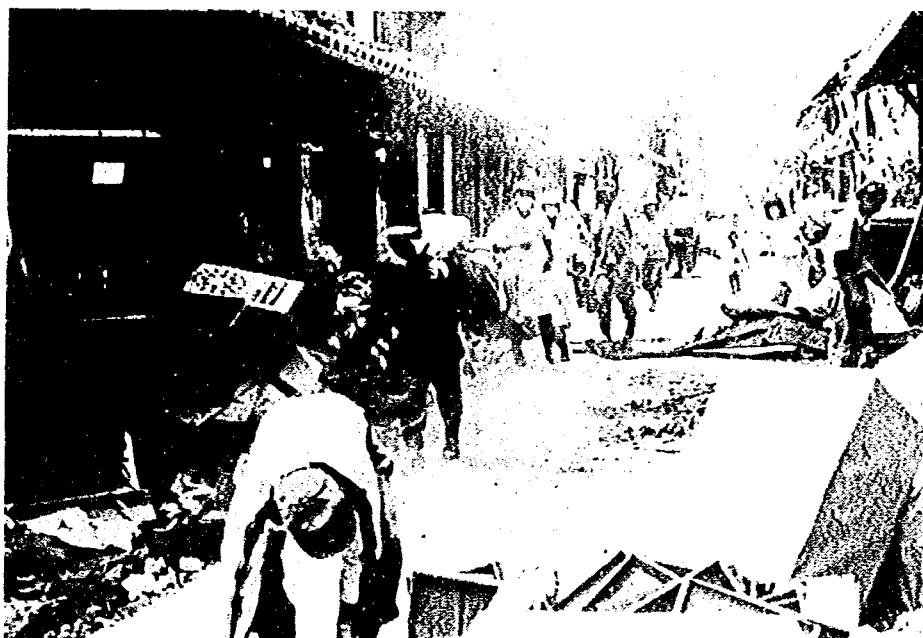
写真-13 路上につまれた水害ゴミ及び防疫活動（山陰水害，三隅町市街）
