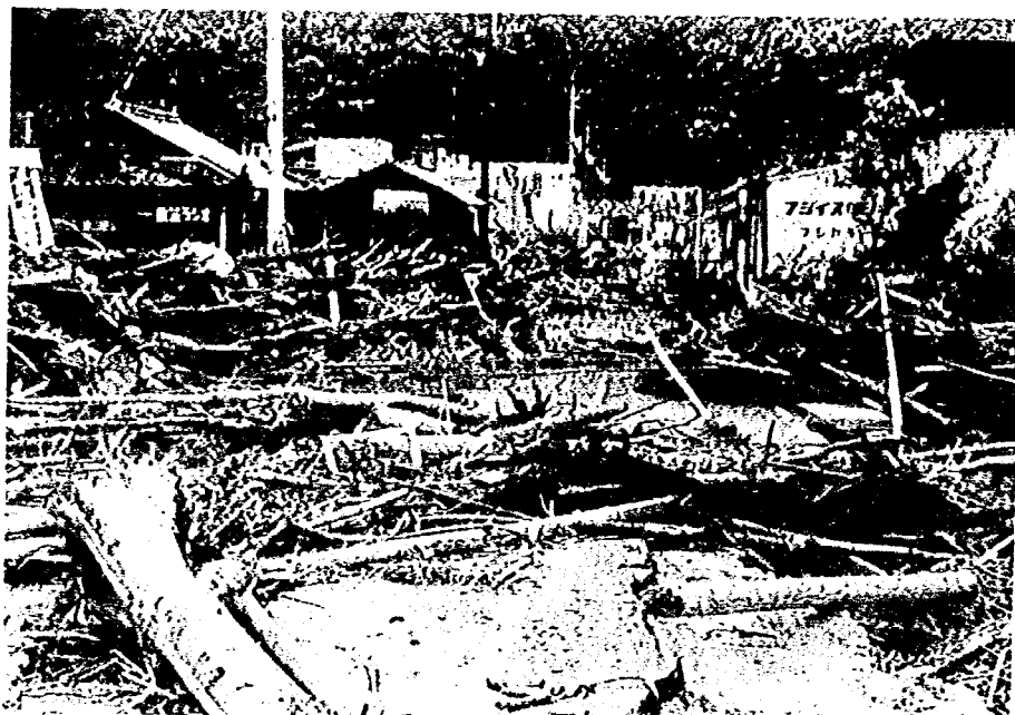
写真－11 濁流後の三隅町市街地の状況（山陰水害）
