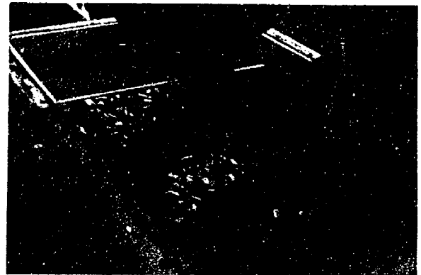
6) 変位計の受板の埋設
